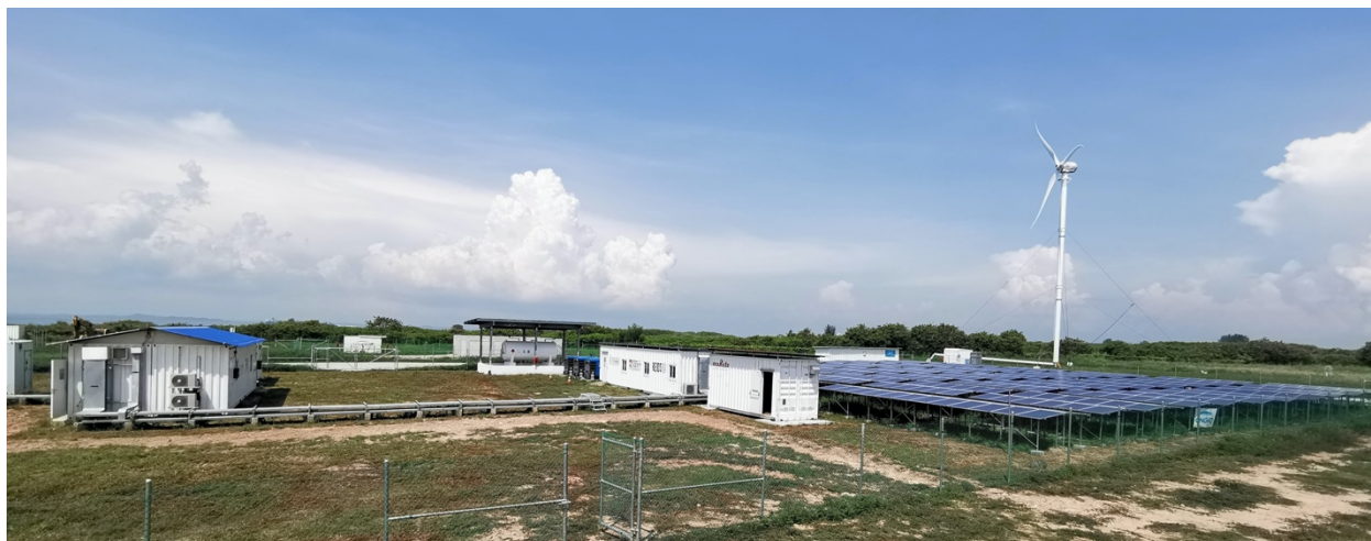
Рисунок 12 Вид на полигон REIDS Фотография IC ENERGYNET
